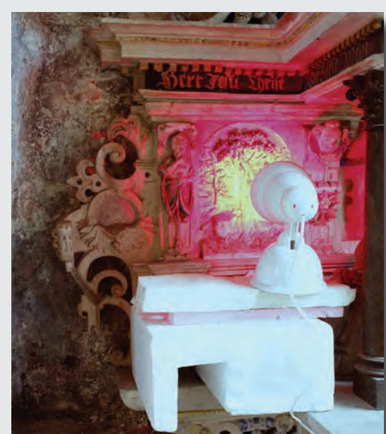
Abb. 2 : schematische Darstellung der Konstruktion (grün - Konsolsteine, rot - Zuganker, gelb - Klammern) | Abb. 3 : Versuchsaufbau der aktiven Thermographie | Abb. 4 : Thermographieaufnahme des selben Ausschnitts, wie in Abb. 3
