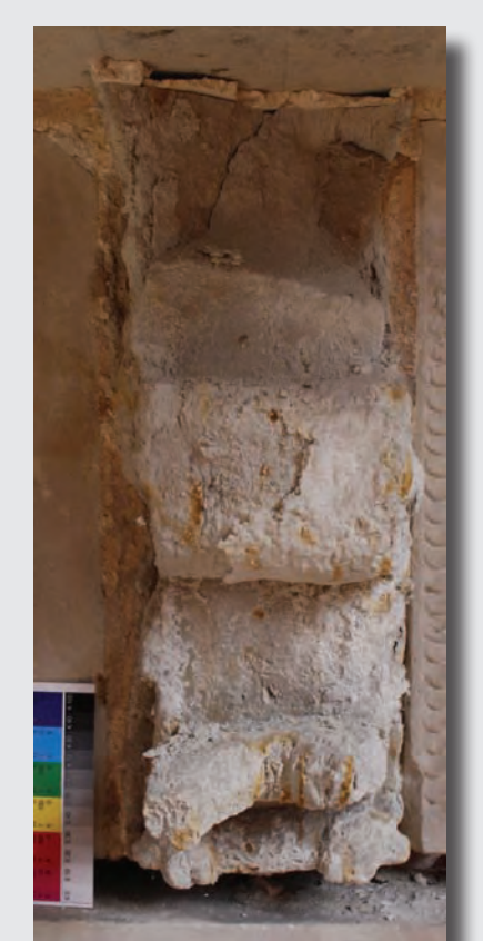
Abb. 10 : Feuchte- & Salzränder im Gewölbe der Seitenkapelle | Abb. 11 : rechter Konsolstein mit Salzkrusten
