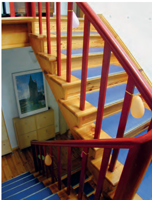
Linoleum als Treppenbelag © Klempnow
