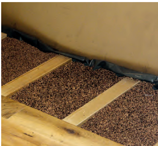
Korkschüttdämmung unter Holzfußboden © Klempnow
