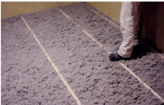
Einblasdämmung Zellulose zwischen Lagerhölzern im Fußboden © Klempnow
