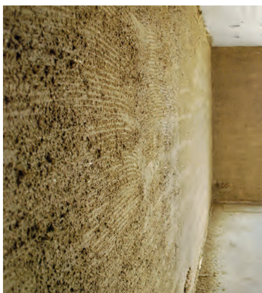
Ausbau mit Lehmsteinen und Lehmputz
