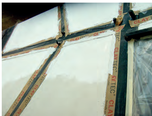
Kalkanstrich auf Lehmausfachung im Fachwerk
