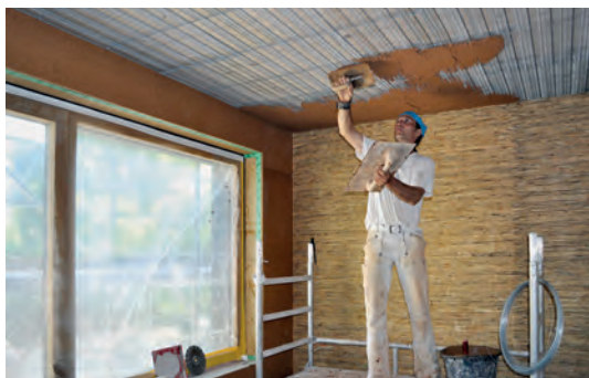
Lehmputz, Wand und Decke, Bambusmatten © Roswag Architekten
